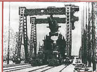
Bild 5. "Dora" under montering. Bakre delen av eldröret håller just på att lyftas på plats.
